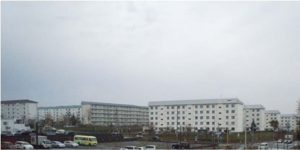
図表 II-20. もみじ台団地内の集合住宅群
