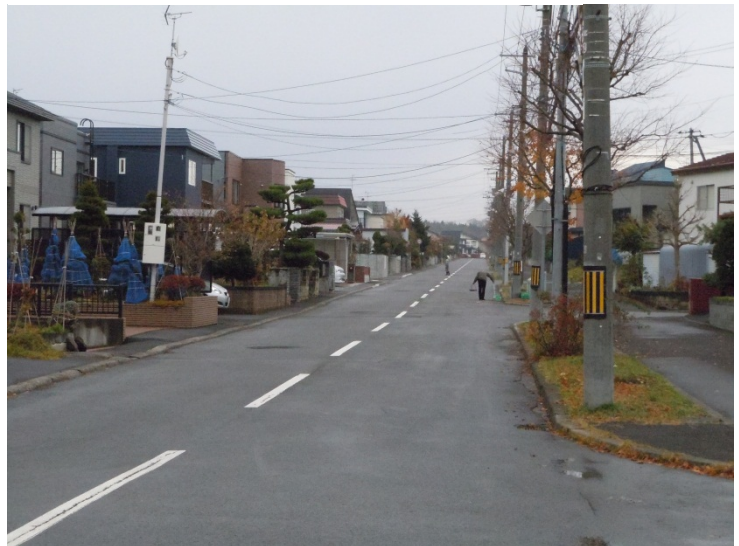
図表 II-21. もみじ台団地内の戸建て住宅街
