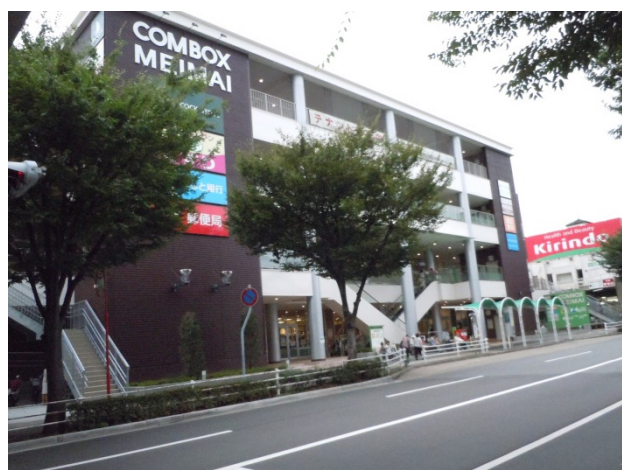
図表 II-8. 商業及び住民交流ゾーンに整備された複合商業施設
